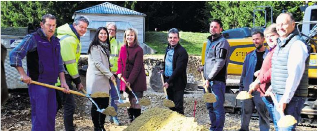
Den Spatenstich unterhalb des alten Hochbehälters (im Hintergrund) vollziehen (von links) Wasserwart Thomas Utz, Sebastian Bajonowski (Planungsbüro Seuss), Kämmerin Lisa Voit (Verwaltungsgemeinschaft Illschwang), Roland Kiesecker (Planungsbüro Seuss), Birgland-Bürgermeisterin Brigitte Bachmann, Verbandsvorsitzender Elmar Halk, Rainer Niebler (Firma Steininger), Christoph Küssperth (Netz-Bau), der Illschwanger Bürgermeister Dieter Dehling und Siegfried Dettmann (Firma Steininger).
